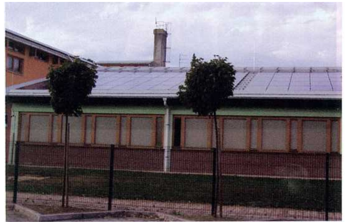
Sončne celice na strehi šole predstavljajo dodatna tveganja tako glede vzdrževanja, kakor glede same požarne varnosti.
